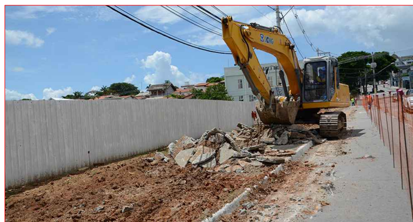
Remoção de Pavimento Intertravado "Paver"
